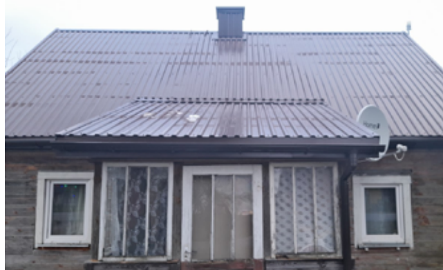
Daivos namų stogas, prieš ir po remonto.
